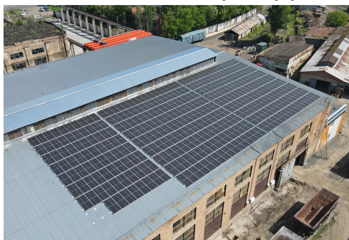
м. Сміла, станція потужністю 200 кВт Вагоноремонтний завод
